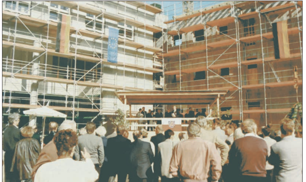
Am 3. Oktober 1995 wurde das Richtfest des Klinikneubaus gefeiert.
