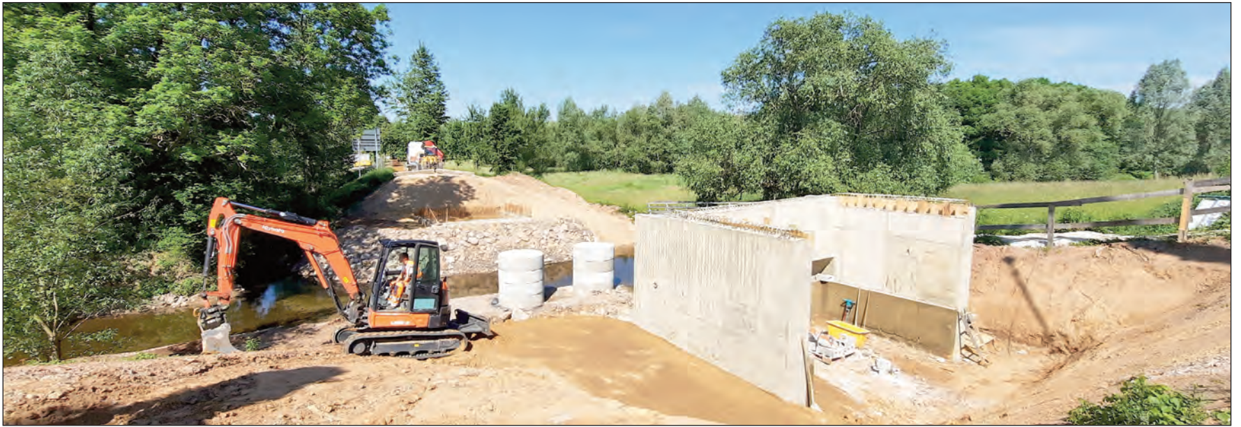
Der alte Pleißenübergang ist bereits vollständig zurückgebaut. Für die neue Brücke werden gerade die Auflager betoniert.
