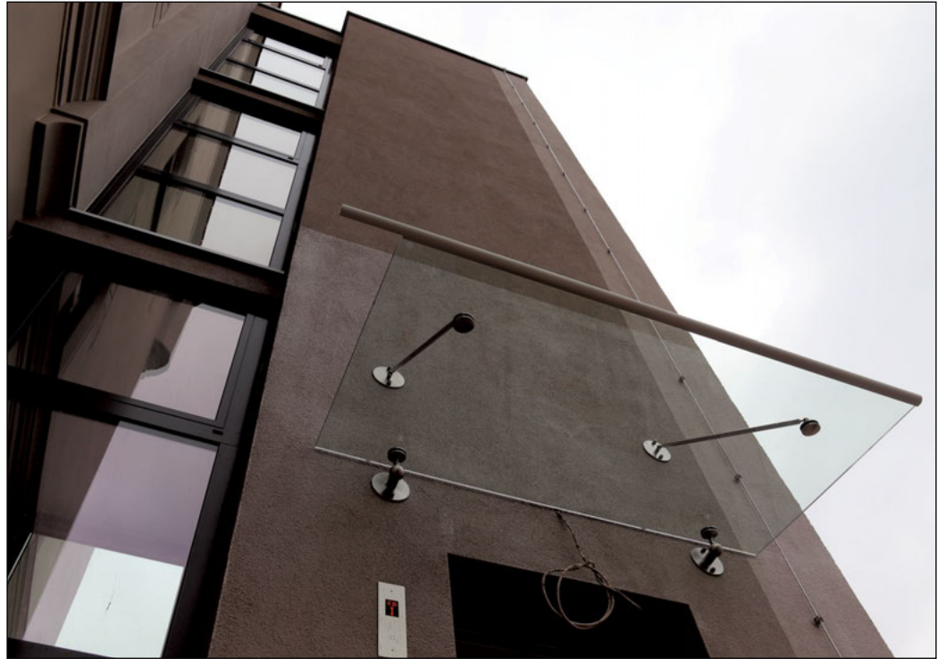
Mit dem neuen Aufzug ist der Zugang zur Außenstelle des Landratsamtes in Schmölln barrierefrei. In den Anbau wurden auch Nistkästen integriert.
