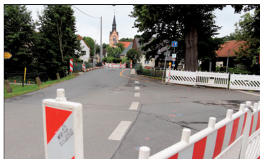
Die Absperrung für die Sanierung steht bereits.
