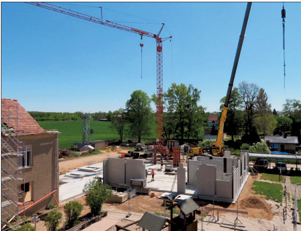
Von den ehemaligen Häusern eins bis drei bleibt nur ein Teil des Hauses drei (Altbau links) stehen, an das der Schulneubau anschließt. Dessen erste Mauern stehen bereits.
