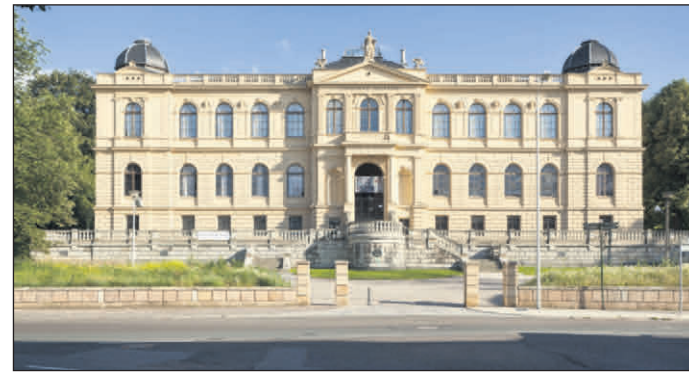
Am 2. Januar 2020 schließt das Lindenau-Museum. Um Baufreiheit für die Sanierung zu schaffen, zieht das Museum mit seinem kompletten Inventar und allen Sammlungen aus seinem Bestandsgebäude aus. Foto: J.M. Pietsch
