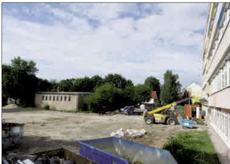
Auf dieser Fläche soll der Anbau an das Bestandsgebäude des Schmöllner Gymnasiums erfolgen
