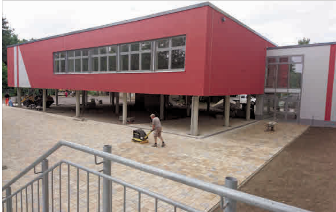
Der Anbau des Roman-Herzog-Gymnasiums in Schmölln
