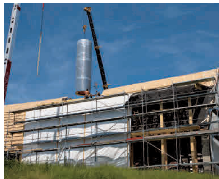
Im Sommer des vergangenen Jahres wurde der Speicher mit einem Kran in das Haus gehoben Foto: Axel Erler
