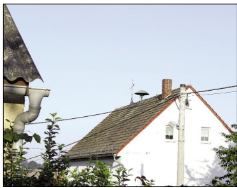
Im Landkreis gibt es vor allem zwei Sirenenarten: Die Mast sirene (Foto oben; Nobitz, OT Klaus) und die Dach sirene (Niederhain)
