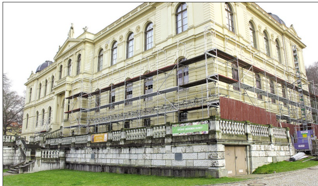
Die Gerüstbauarbeiten im Zuge der Dachsanierung des Altenburger Lindenau-Museums sind in vollem Gange. Die Baumaßnahmen sollen bis zum Herbst abgeschlossen sein.
