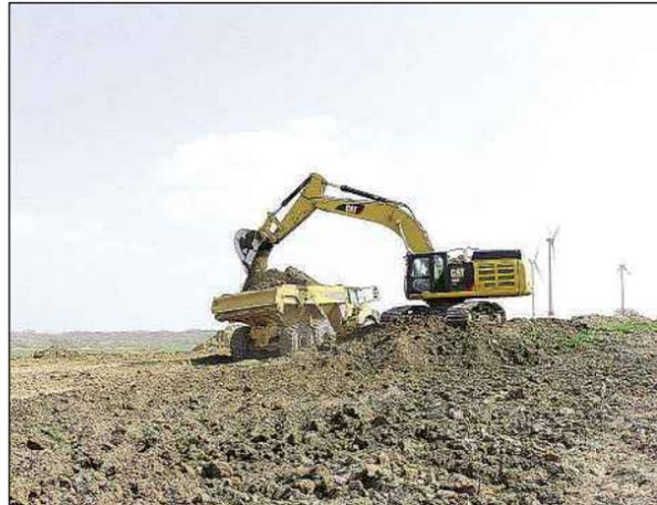
Ein Bagger trägt den Mutterboden ab und belädt einen Dumper, der die Erde abfährt. Später wird sie dann wieder zur Rekultivierung des Tagebau-Areals genutzt.
