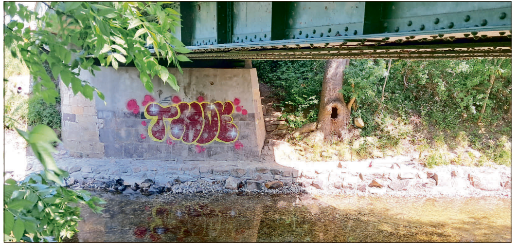
Die fertiggestellte Otterberme am nördlichen Widerlager der Pleißebrücke in Zschechwitz.
