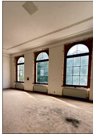
Die aufgearbeiteten Fenster.
