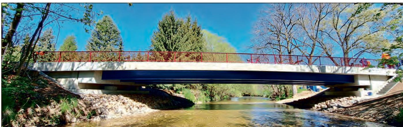
Seit 30. April 2026 rollt der Verkehr über die neue Pleißebrücke in Kotteritz.
