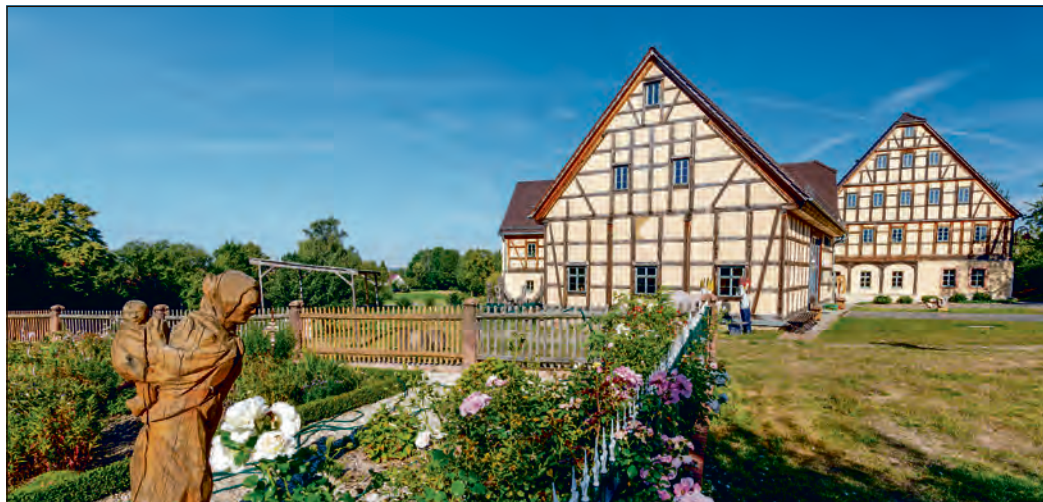
Der Quellenhof Garbisdorf ist ortsbildprägend – ein Vierseithof, umgeben von Obstgärten und einem Teich auf einem Wiesengrundstück von 18.000 Quadratmetern. Foto: Carsten Schenker
