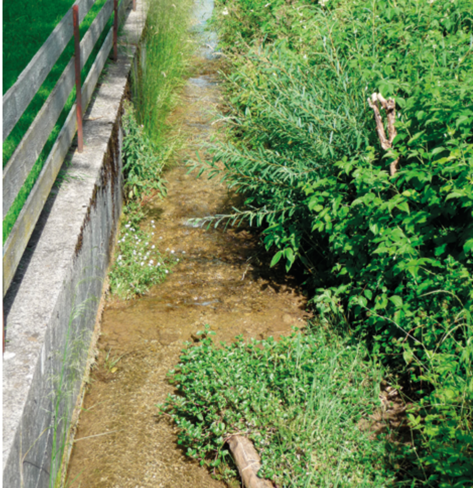
Abb. 66: Selbst ein kleiner Dorfbach wie hier in der Gemeinde Bernbeuren kann zur Sturzflut werden!
