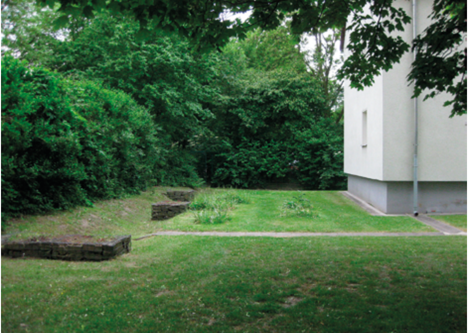
Abb. 93: Gartenanlage mit offenem Regenabfluss und Sickermulde
