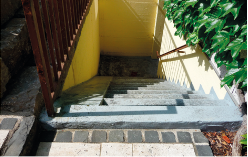
Abb. 89: Aufkantung einer Kellertreppe. Zusätzlich ist unten ein Kanalabfluss verbaut.
