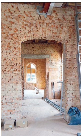
Neue Türrdurchbrüche für Flucht- und Rettungswege.
