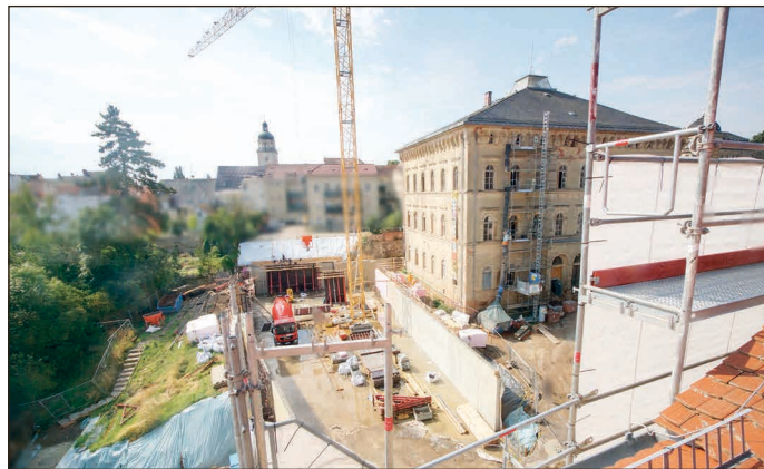
Aushub der Baugrube 2025.
