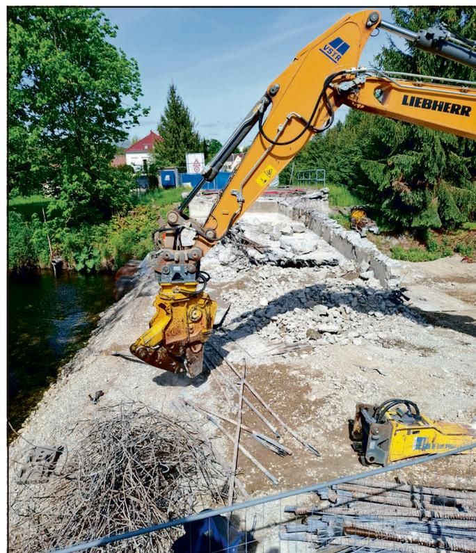
Einsatz mit der Hydraulikschere.
