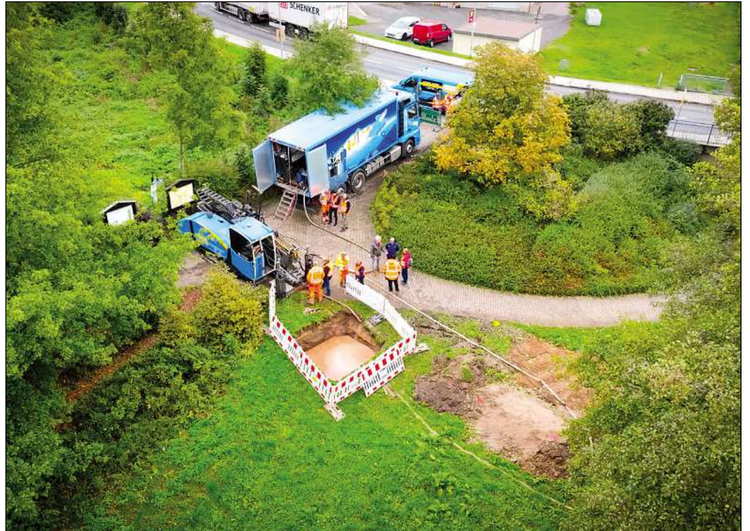
Baugrube für die Eisenbahnquerung in Schmölln.
