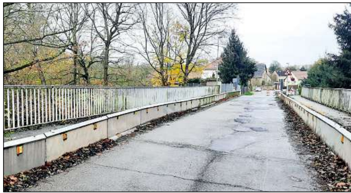
Die Brücke wird abgerissen und neu gebaut.
