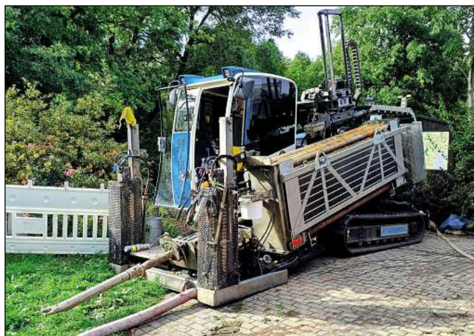
Spülbohranlagen ermöglichen die Unterquerung von Gewässern, Straßen und Gleisanlagen
