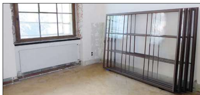
Die Fenster werden restauriert bzw. originalgetreu nachgebaut.
