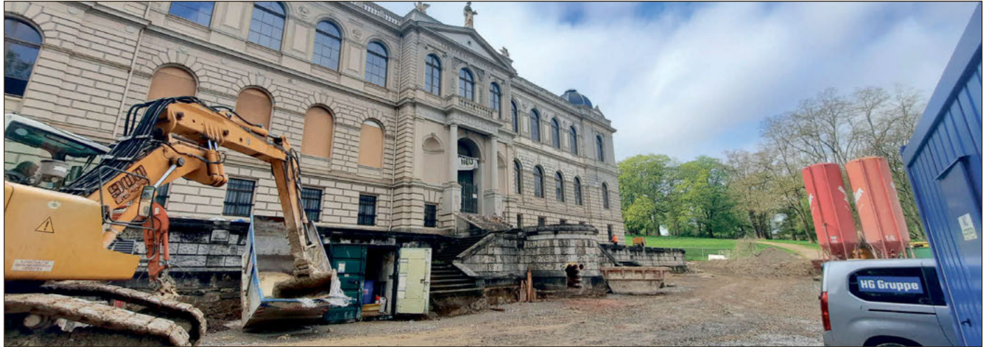
Das Lindenau-Museum ist eine Großbaustelle.
