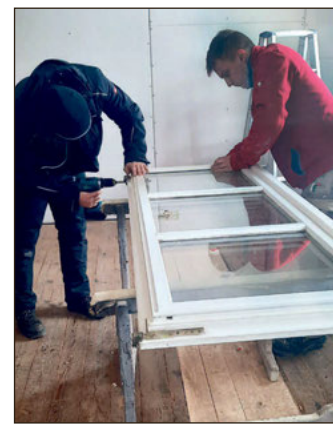
155 Holzfenster werden nach und nach saniert.
