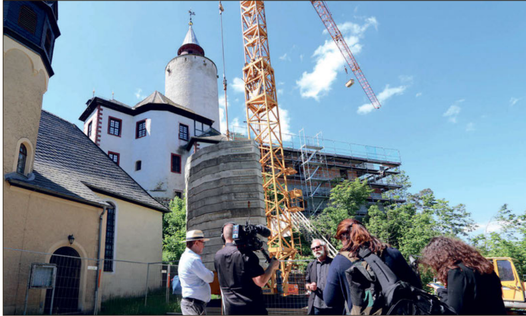
Beim Pressetermin erinnert Museumsdirektor Klaus Hofmann (Mitte) daran, dass auch in der Vergangenheit das Baumaterial knapp 30 Meter nach oben musste, wofür es heute einen Kran gibt.
