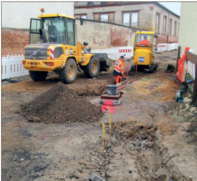
Im Zuge der Fahrbahnerneuerung in Molbitz wird unter anderem auch der Abwasserkanal erneuert.
