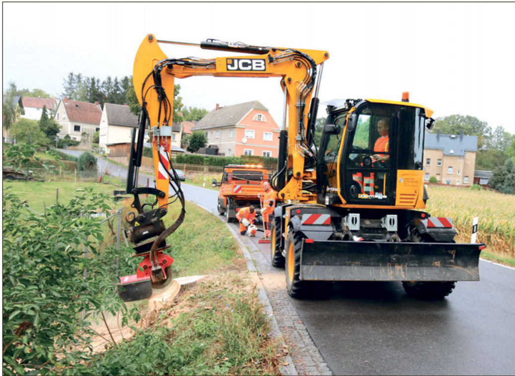
Die Mitarbeiter der Kreisstraßenmeisterei kümmern sich im Herbst unter anderem um die Pflege der Gehölze am Straßenrand.
