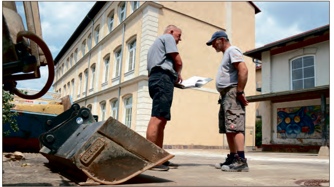
Schon vor Beginn der Ferien sind die Arbeiten für die digitale Netzwerkinfrastruktur der Regelschule „Am Eichberg“ in Schmölln angelaufen. Hausmeister Thomas Ludwig (l.) stimmt sich mit Dirk Naundorf vom Baggerbetrieb Burkhardt ab.
