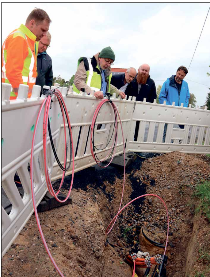
Michael Riecke (3. v.l.) vom Projektträger Breitbandförderung begutachtet gemeinsam mit Vertretern der Telekom und der Tiefbau-firma OFM Communications eine Glasfaser-Baustelle bei Maltis.
