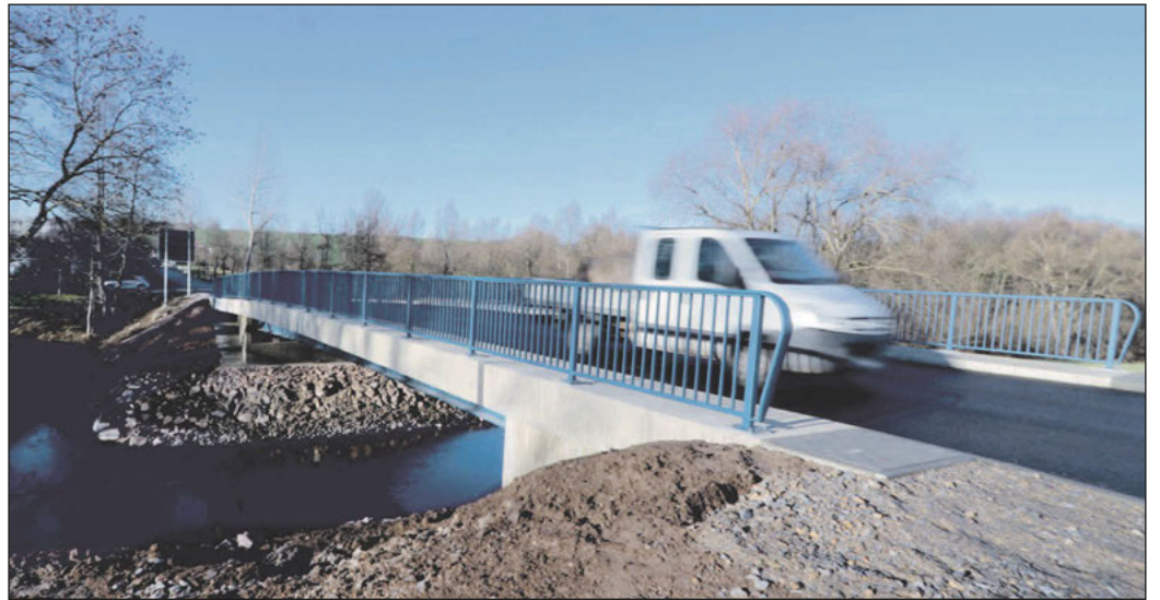
Die neue 25 Meter lange Betonbrücke ist für den Verkehr frei.
