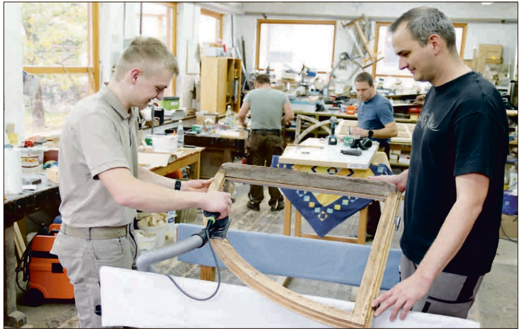
Tischlermeister Christian Kalkoff (r.) und Geselle Franz Mühle bei der Restaurierung der historischen Fensterrahmen.
